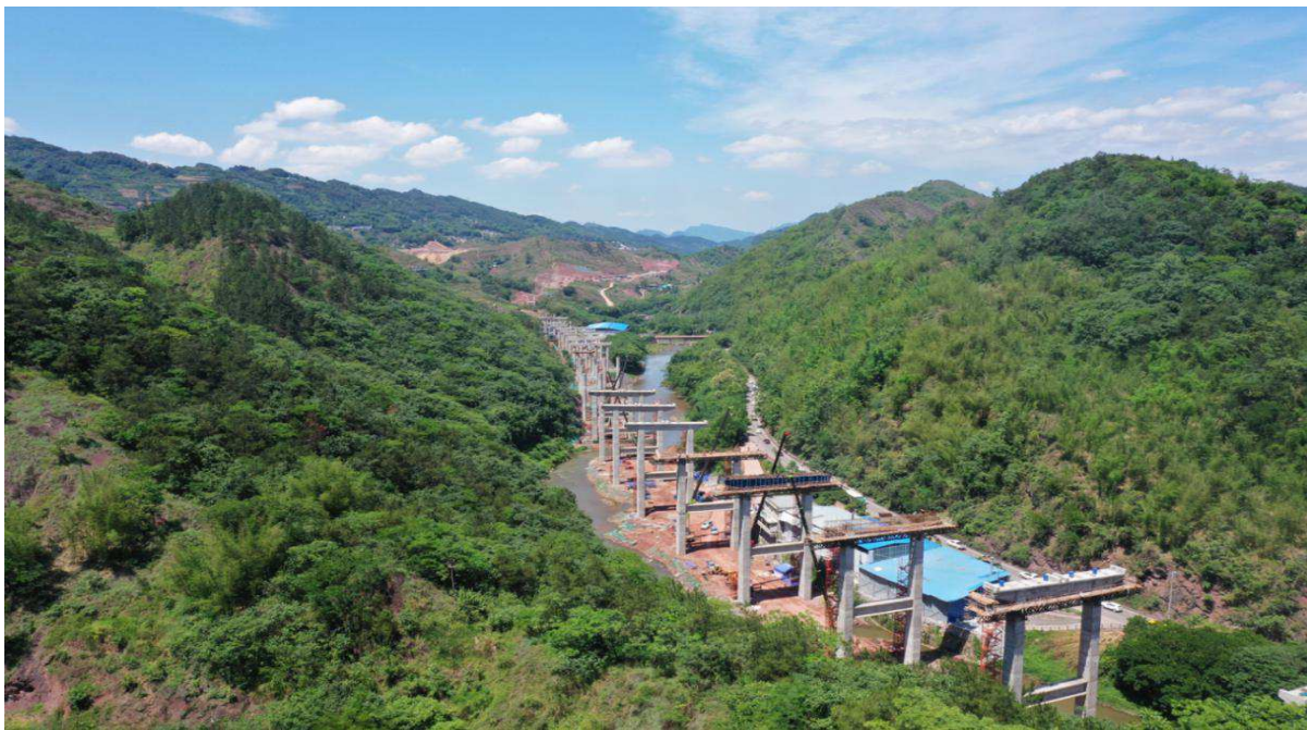
(宜宾城市过境高速公路西段和宜宾至彝良高速公路(四川境)现场图)
